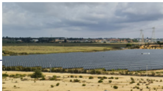
Paneles solares - Fuente: Exolum
